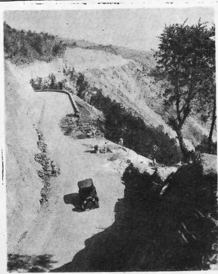
Trazo atrevido en lo alto de las montañas en la carretera de México a Acapulco. Este tramo conduce a Cuernavaca.
